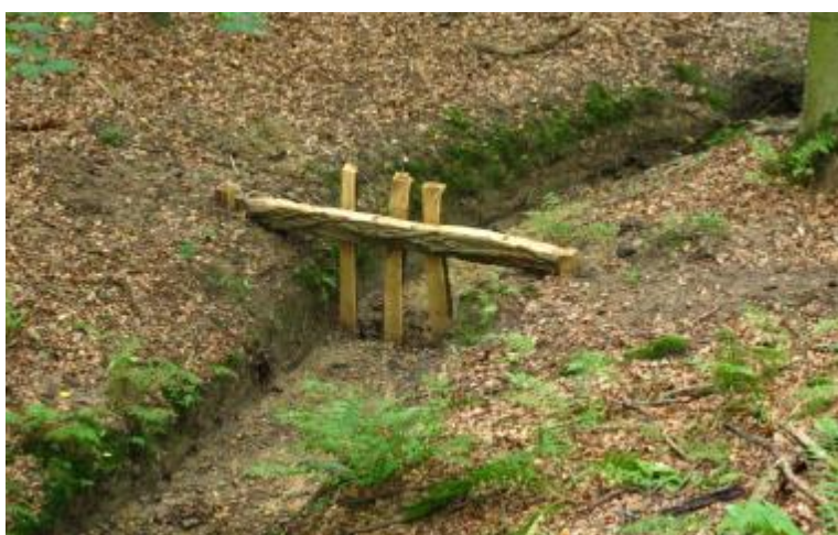
Photo 5 - Piège à embâcles dans un fossé
