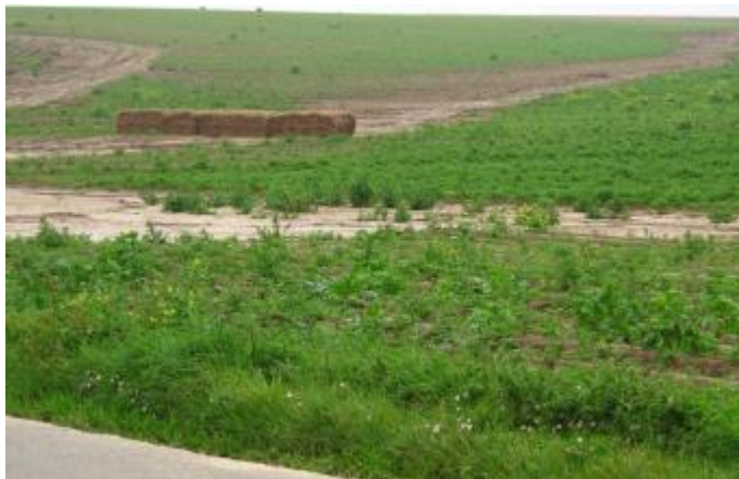
Photo 4 - Déviation d'urgence d'un axe d'écoulement par des ballots de paille de grand format
